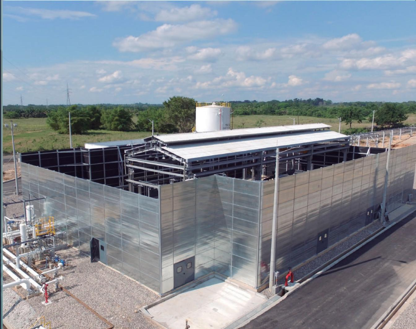
Las pantallas acústicas utilizan el principio de difracción.
